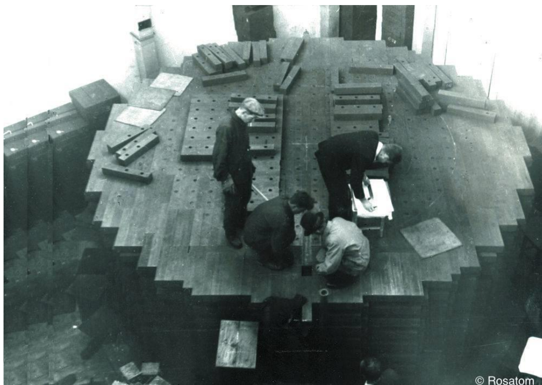
Rys. 9 Rdzeń reaktora F-1 [20]
